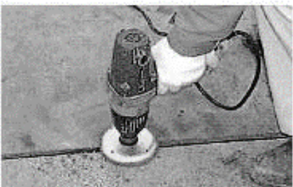
(4)センターボルトの締め付けを行います。
