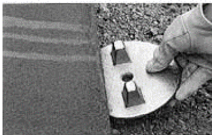
(1)リンクプレート下部を敷鉄板に挿入します。
